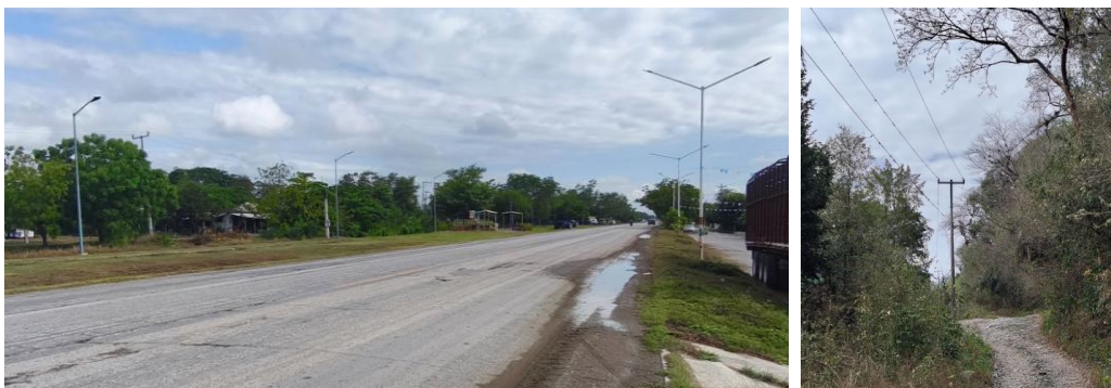
Imagen 40. Infraestructura eléctrica en Loma Alta y camino hacia Alta Cima
