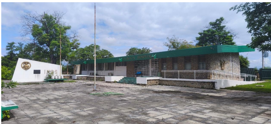
Imagen 13. Clínica-hospital en el municipio de Gómez Farías
